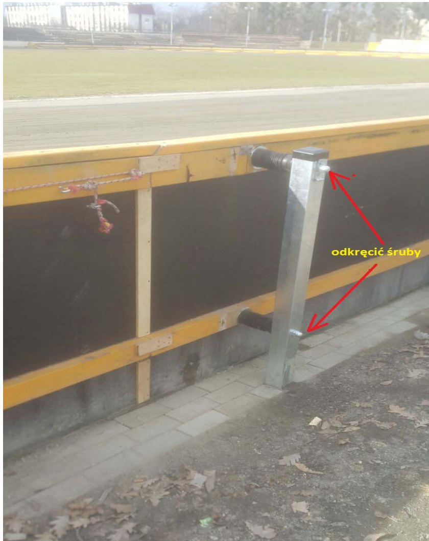
rys. 1. Śruby do odkręcenia w przypadku wymiany modułu
